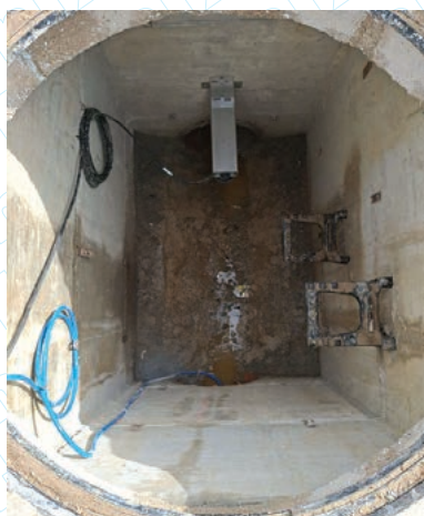
Mjerači protoka na ulazu / izlazu UPOV-a
