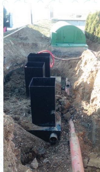
Ugradnja prihvatne komore na postojeći kanalizacijski sustav
