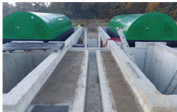
Izveden dovodni kanal prema biorotorima i ugrađen sustav zapornica
