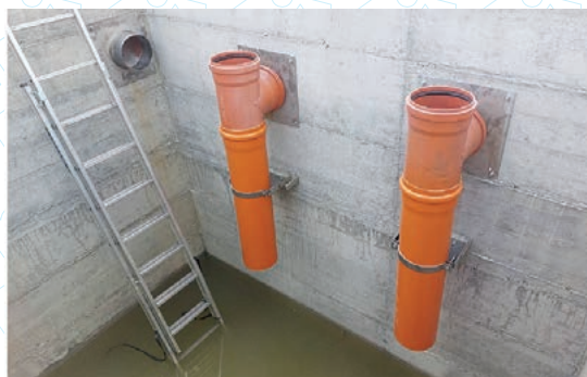
Preljevni potopljeni sifon
