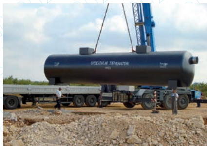
Prikaz ugradnje specijalnih separatora na terenu
