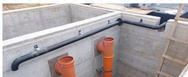
Cjevovod povrata mulja
