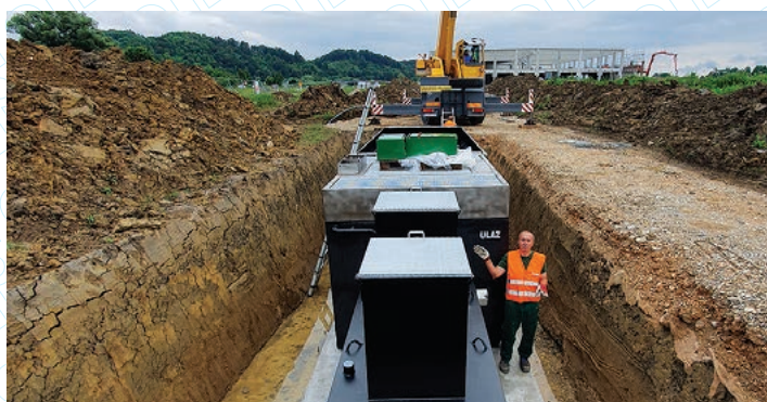
Nadzor i kontrola ugradnje uređaja
