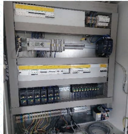
Upravljački elektroormar sa SCAD- om, PLC-om, i signalizacijom
