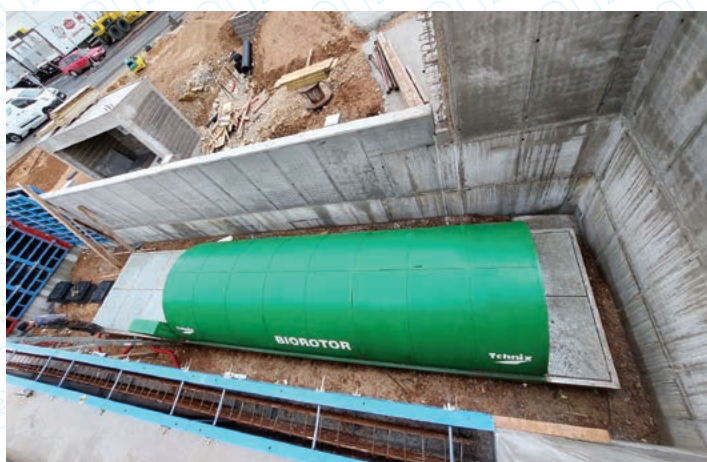
Ugradnja u betonski bazen
