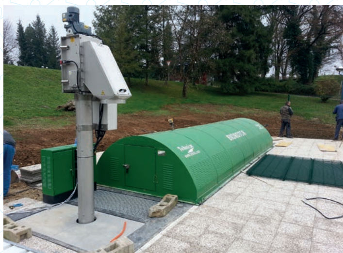
U sklopu kompleksa hotela - biorotor sa automatskim izvlačem krutina
