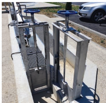
Zapornice u betonskom kanalu
