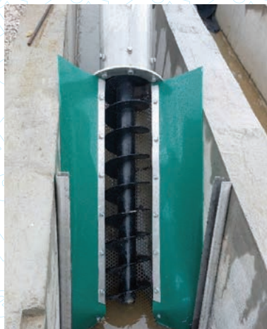
Pužni separator ugrađen u betonski kanal i sustav zapornica
