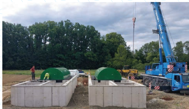
Ugradnja biorotora 2x650 ES
