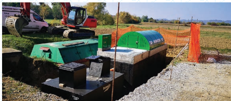
Zamjena uređaja staro za novo - kanalizacija je cijelo vrijeme bila u funkciji, trajanje radova sedam dana
