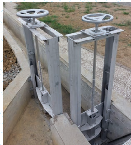
Pužni separator ugrađen u betonski kanal i sustav zapornica
