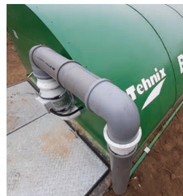
Prisilna ventilacija upuhivanja ili izvlačenja zraka
