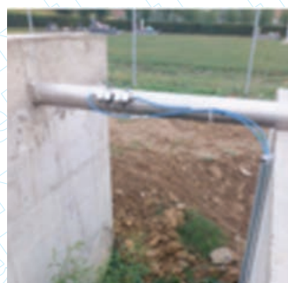
Mjerač protoka na tlačnoj cijevi
