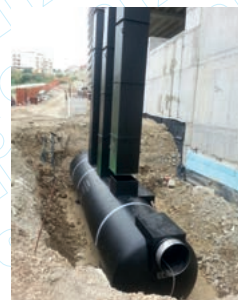
Specijalni separator s bypassom
