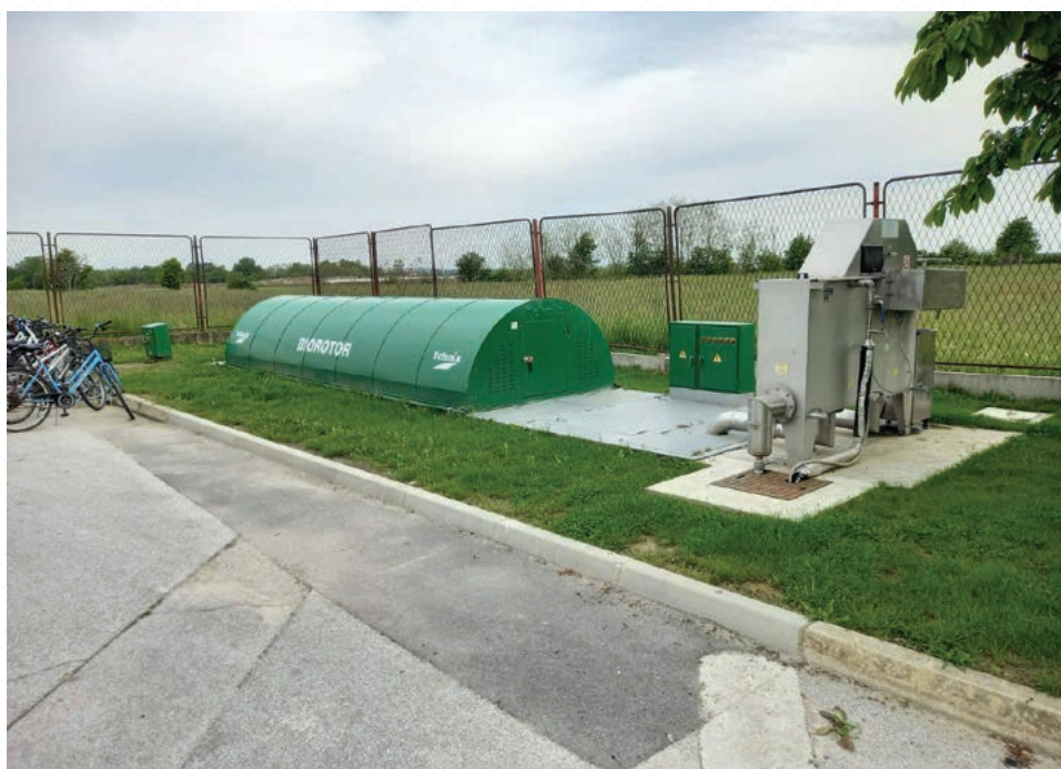
INOX biorotor s automatskim mehaničkim izvlakačem tkanina
