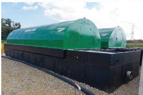
Biorotor 800 + 800 ES-a, paralelan rad
