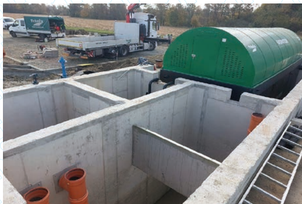
Biorotor s prihvatnom komorom, egalizacijski bazen i aeracijska komora
