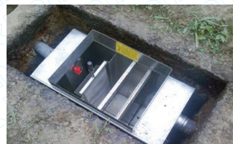
Prikaz ugradnje mastolova
