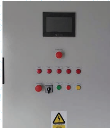
Upravljački elektroormar sa SCAD- om, PLC-om, i signalizacijom
