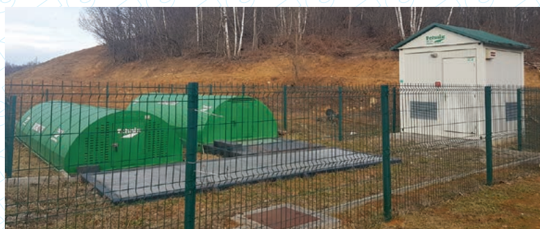
Nadogradnja nove biorotorske jedinice uz postojeći uređaj
