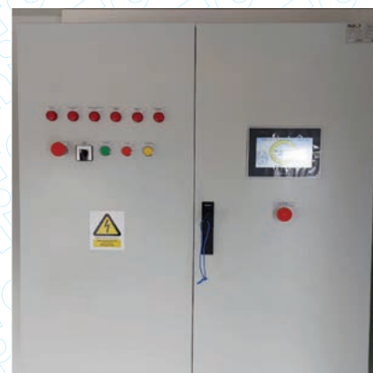
Upravljački elektroormar sa SCAD-om, PLC-om, i signalizacijom
