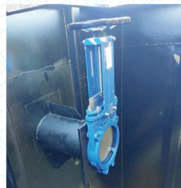
Zapornica za regulaciju dotoka vode u biorotor
