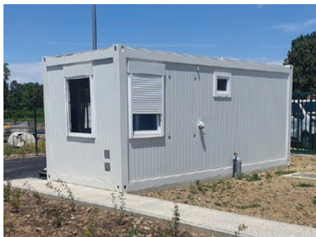
Upravljačko skladišni modul
