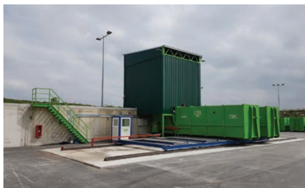
Pretovarna stanica Pirovac, kapacitet 269 m 3 /h
