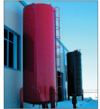
Vertikale Behälter nach DIN 6618
