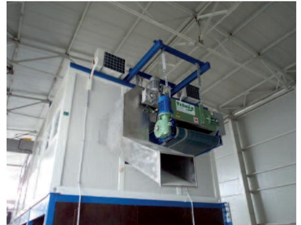
Magnetischer Metallscheider am Ausgang aus der Sortieranlage
